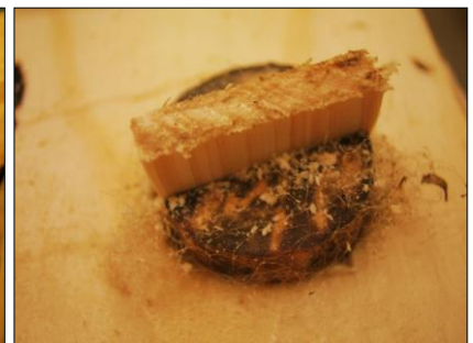
Tappi on kiilattu alapuolelta, tiivisteenä villaa
