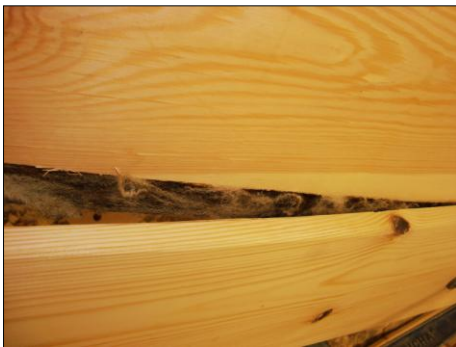
Tervaa ja villaa lautojen välissä
