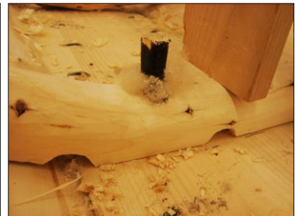
Kaaren kiinnitys tervatuilla tapeilla
